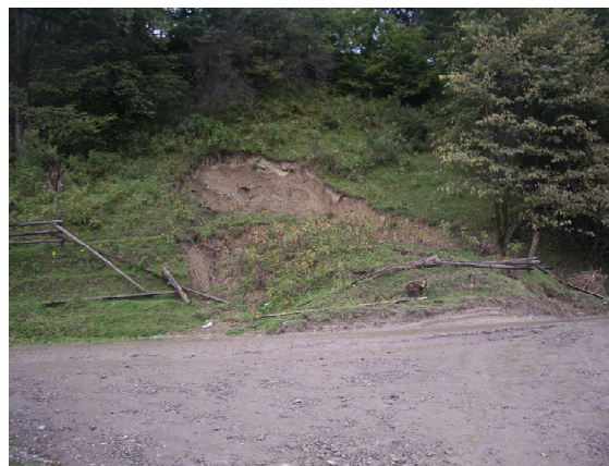
Рис. 2. Формування осувних тіл у нижній частині осувонебезпечної ділянки та часткове перекриття автомобільної дороги Ільці-Буркут
